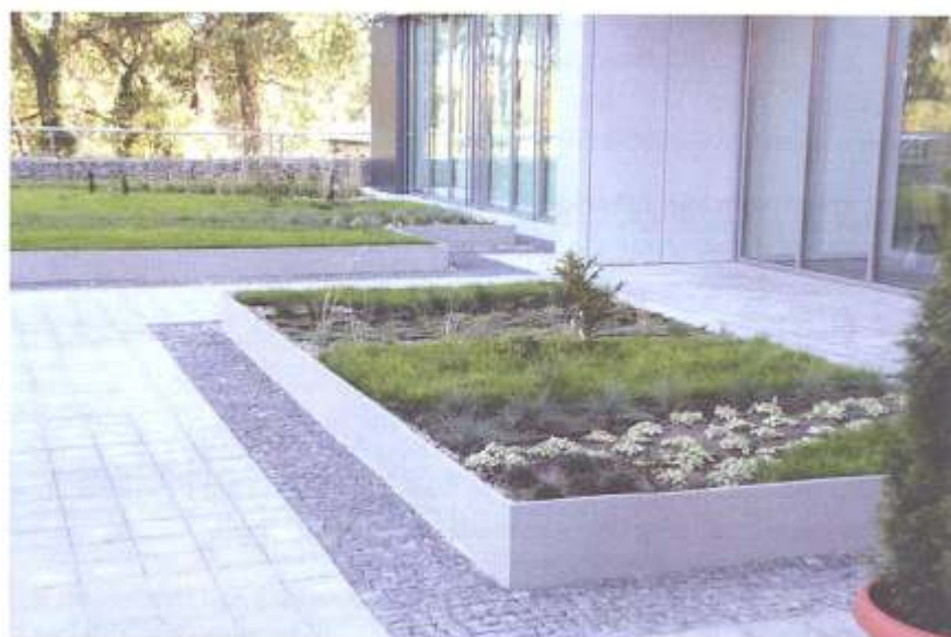
Rys. 8.2. Strefa wejściowa do biurowca Górnośląskiego Parku Przemysłowego, fot. autor Fig. 8.2. Entrance to the office building of Upper Silesian Industrial Park
