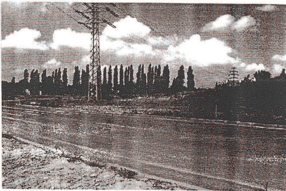
Rys.3. Widok na stan obecny jednego ze zjazdów z Drogowej Trasy Średnicowej na granicy Katowic i Chorzowa.
